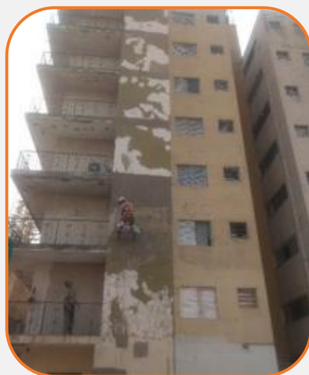
Condomínio Ed. Monte das Oliveiras
